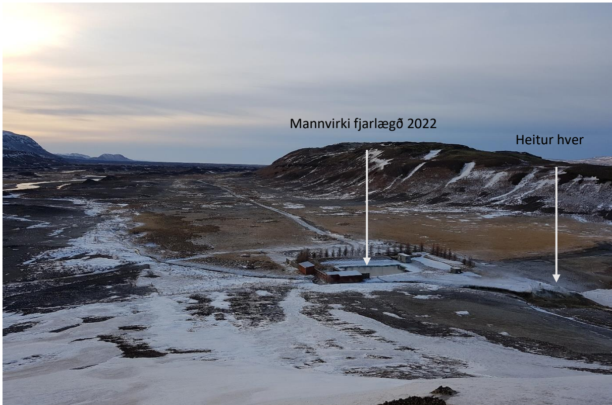
MYND 2. Horft til suðurs úr hliðum Rauðakambs yfir eldri mannvirki og hluta af framkvæmdasvæði A.
