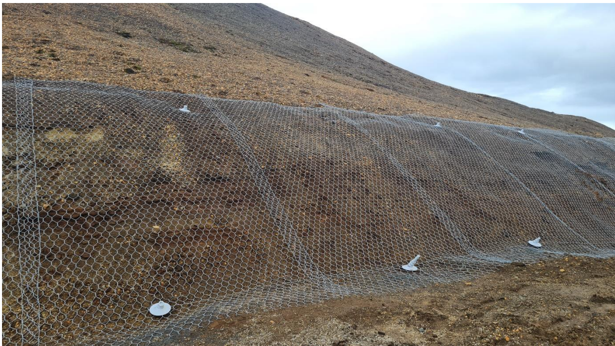
MYND 9. Frágangur nets í suðurhlíðum Rauðukamba, mynd tekin í apríl 2023.
